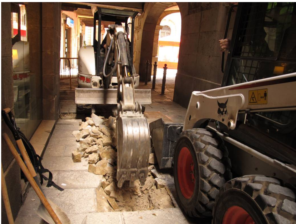
Foto 4: Realització d'una cata a l'immoble 3 extrem oest del carrer
