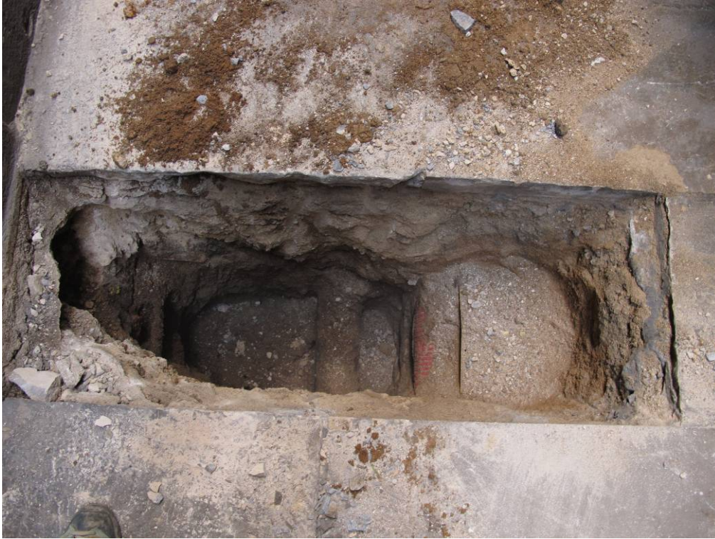
Foto 5: Cata a l'immoble 3 extrem oest del carrer. Zona descartada
